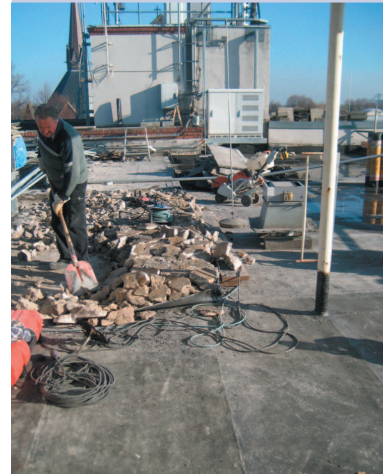
Wochenlanger Abbruch – Der feucht gewordene Estrich musste komplett abgetragen werden.
