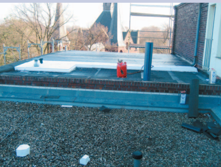
Über den Dächern von Hehn – Ein ungewöhnlicher Blick auf das Dach der Hehner Pfarrkirche
