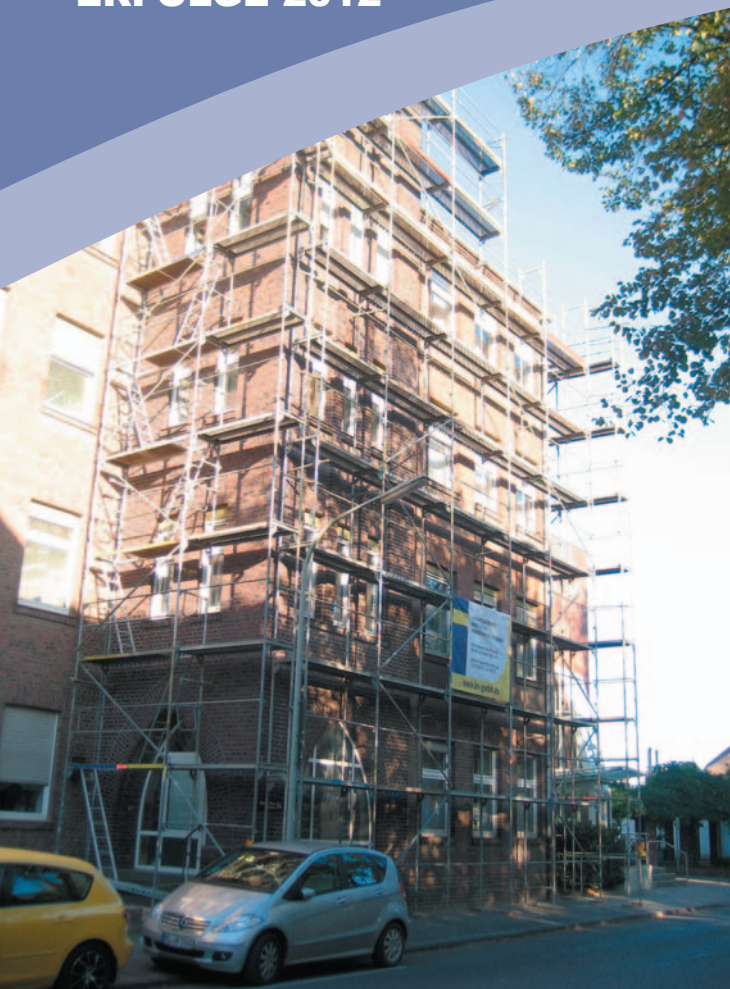
Dacharbeiten – Schon wieder stand ein Gerüst an der Einrichtung. Die Dacharbeiten wurden Ende 2011 abgeschlossen.
