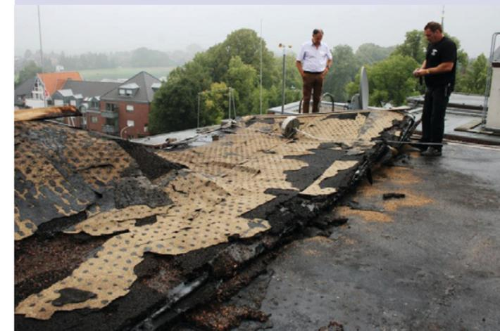
*Ein Unwetter am 28. Juli 2014 zerstörte das Flachdach, unter dem die Belüftungsanlage steht. Es wurde regelrecht weggeklappt.*
